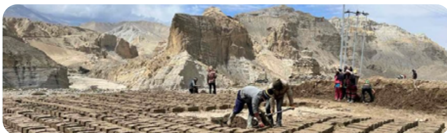
Construction de nouvelles infrastructures (école, salle communautaire, guest house, dispensaire, etc.)
